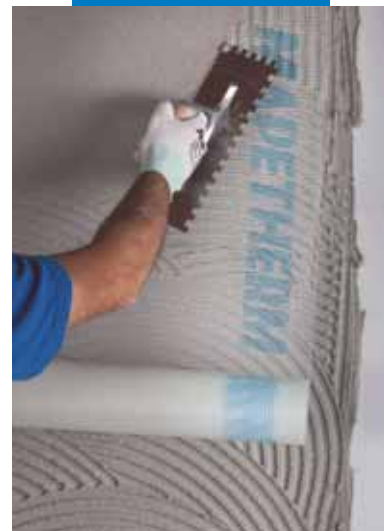
Esecuzione della rasatura armata con interposizione della rete Mapetherm Net
