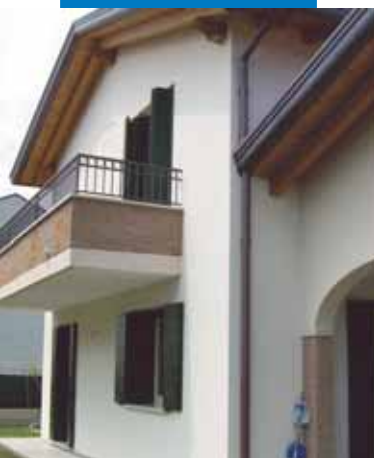
Reggio Emilia - Italia - Realizzazione di abitazione privata con Mapetherm AR1 GG
